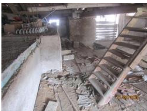
terzo piano, scale per il soppalco (quarto piano)
