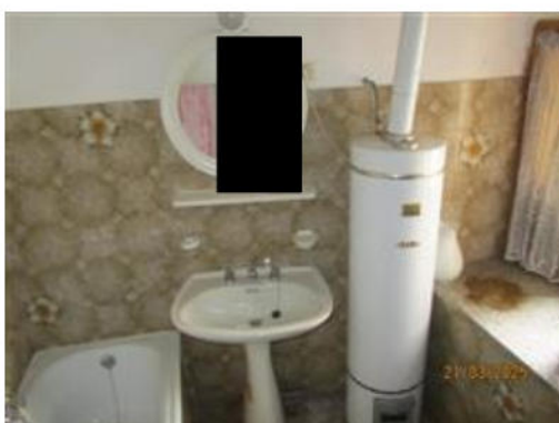
primo piano - bagno
