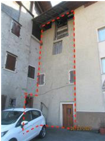
in evidenza il bene p.ed. 76 p.m.5 - lato nord
